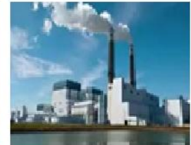
nhà máy điện power plant
