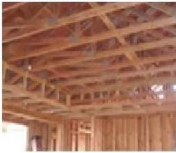
rui mái nhà rafters
