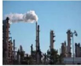
nhà máy tinh chế dầu refinery
