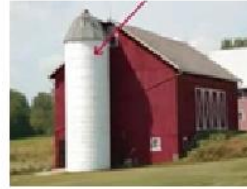
hầm ủ silo
