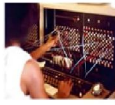
tổng đài switchboard
