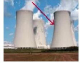
tháp làm nguội cooling tower
