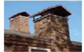
ống khói chimney
