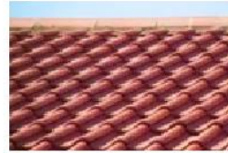
mái nhà roof
