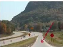
lối vào đường nối entrance ramp
