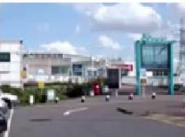
khu vực dịch vụ service area
