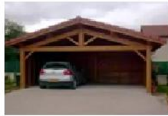
nhà để ô tô garage
