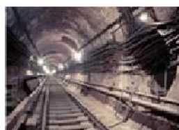
đường hầm Tunnel
