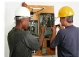
thợ điện electrician
