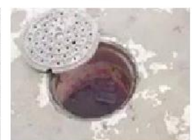
miệng cống manhole
